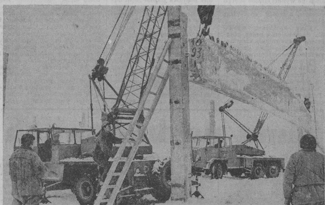
Zima jest trudnym okresem dla budowlanych. NA ZDJĘCIU: budowa Fabryki Domów w Suwałkach, przy pracy brygada montażystów Ryszarda Radzewicza. Fot. Zdzisław Lenkiewicz
