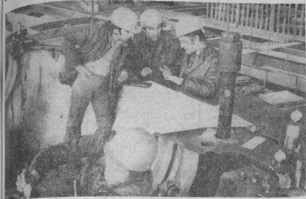
W Elektrowni Kozienice do końca bieżącego roku nastąpi rozruch pierwszej w Polsce turbiny o mocy 500 megawatów. Prototyp tego bloku energetycznego jest dla nas technologiczną nowością. Kozienicy energetycy muszą poradzić sobie ze skomplikowanymi operacjami, a pomagają im w tym radziszcy specjaliści. NA ZDJĘCIU: inż. Aleksander Libenson z Leningradzkiego Zakładu Maszynowego i Energetyki, inż. Jerzy Piotrowski i inż. Mirosław Gonczarow z Energomontażu CAF — Stan — telefotom "Północ".
