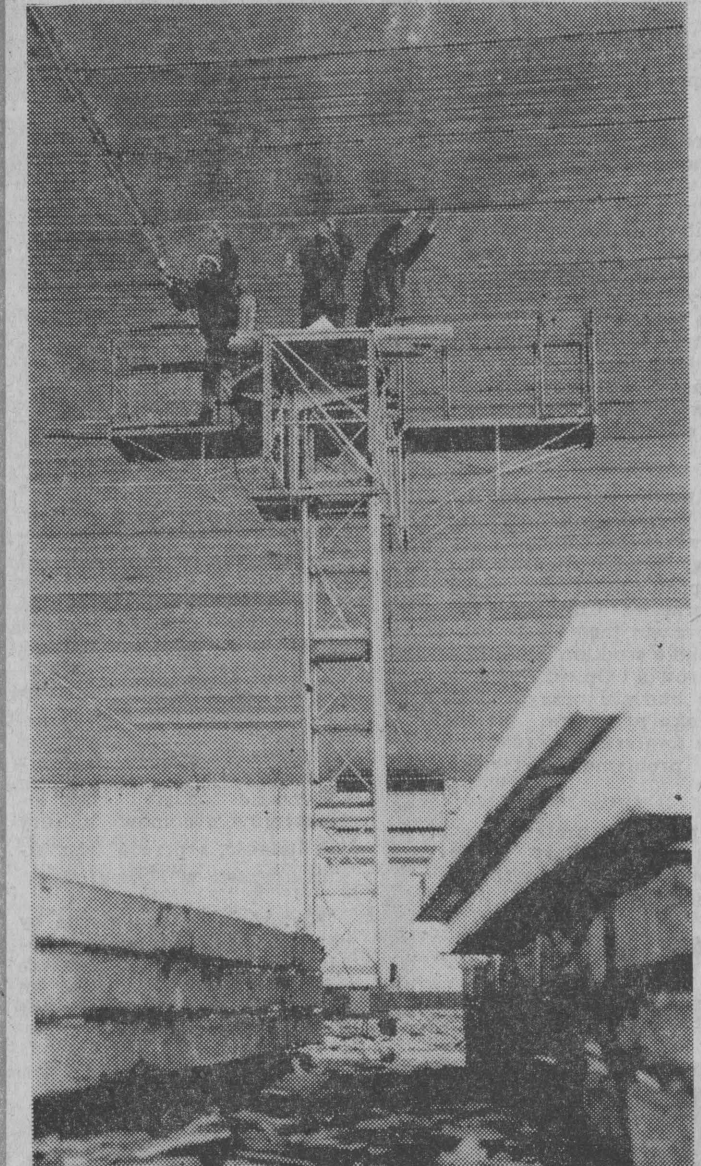
Brygada Zdzisława Borzeckiego z wrocławskiego „Mostostalu” przy montażu zamrażalni. Zdjęcia: Janusz Podziwski
