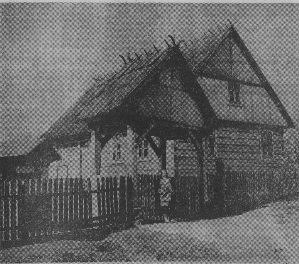
Zrekonstruowana chałupa mazurska w Oraczach k. Elku. W tym zabytkowym obiekcie zlokalizowano punkt biblioteczny.
