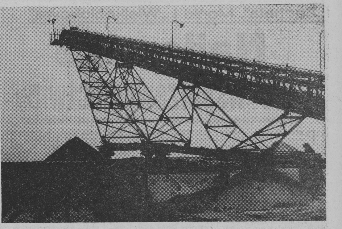
Gotowy produkt zakładu wędruje taśmociągami do specjalnego zasobnika, zdolnego pomieścić 50 tys. ton mieszanki piaskowo-żwirowej. Fot. K. Swiderski
