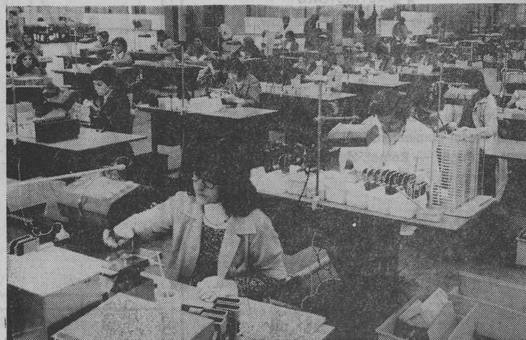
W Zakładzie Podzespołów Telewizyjnych w Białymstoku — hala montażu płytek podzespołów odborników telewizyjnych.
