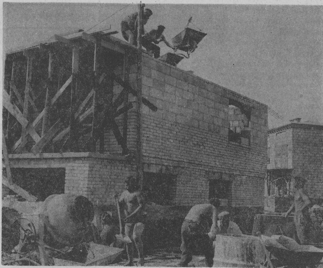
Przy budowie domu Tadeusza Sulewskiego pracuje brygada Jerzego Adamowicza.
