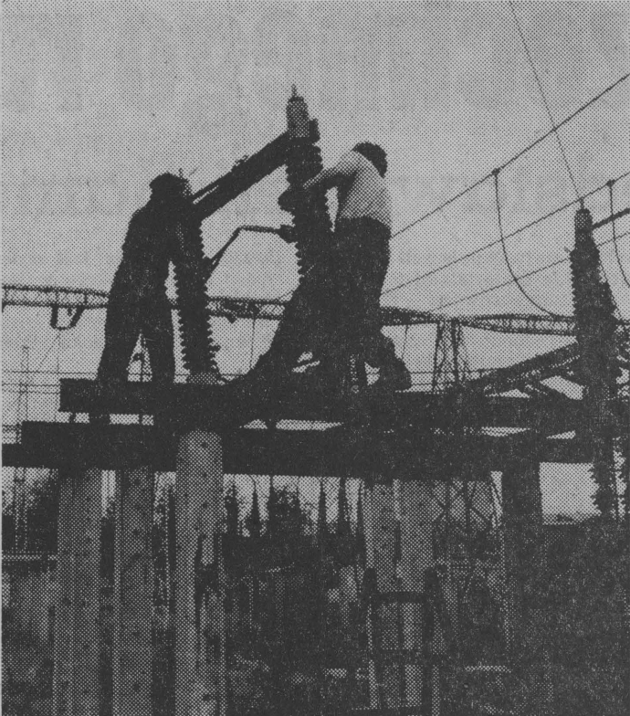
Montażem odcinka 110 kV w rozdzielni napowietrznej zajmuje się brygada Mariana Doroszczyka z katowickiej „Elektrbudowy”.
