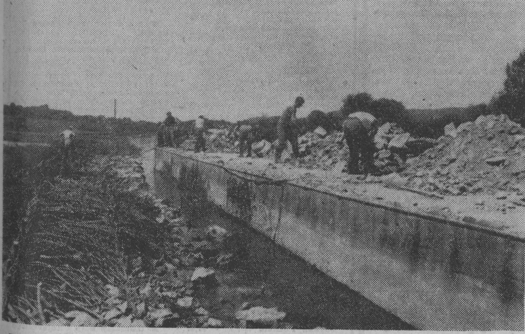
Zanim rozpoczną się na większą skalę prace nad zagospodarowaniem Wisły i jej dorzeczy, bieżące roboty nad utrzymaniem i niżej brzegowych rzeki na odcinku 150 km, od Oświęcimia do Opatowa wykonuje Przedsiębiorstwo Budownictwa Wodno-Inżynierskiego w Krakowie. NA ZDJĘCIU: Brygada Jana Kuglina w czasie umacniania brzegów Wisły w okolicy Tyńca. CAF—Sochor—teletext
