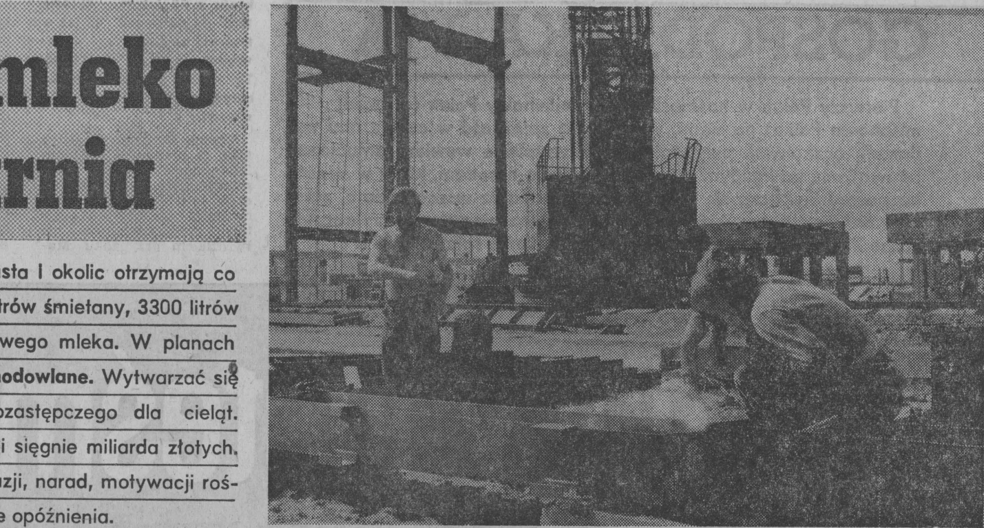
Najbardziej zagrożonym odcinkiem robót jest węzeł ciepłowniczy. Przy pracy brzygada Zdzisława Wiśniewskiego.
