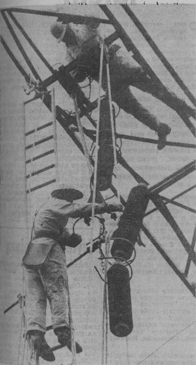
CSRS. Dzięki wprowadzeniu nowej techniki, opracowanej przez specjalistów w NRD, Czechosłowacji, monterzy mogą reperować sieć energetyczną pod napięciem, bez wyłączenia prądu. NA ZDJĘCIU: prasy monterzy wymieniają izolatory sieci pod napięciem. CAF—CTK
