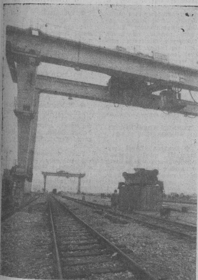
Powstaje duża stacja kontenerowa PKP Łódź-Olechów. Budowę stacji rozpoczęto w 1975 roku. Obecnie prowadzone są prace przy betonowaniu placów składowych. Zakonczenie budowy przewidziane jest na III kwartał bieżącego roku. Baza PKP-Olechów będzie jedną z największych w kraju stacją kontenerową.
