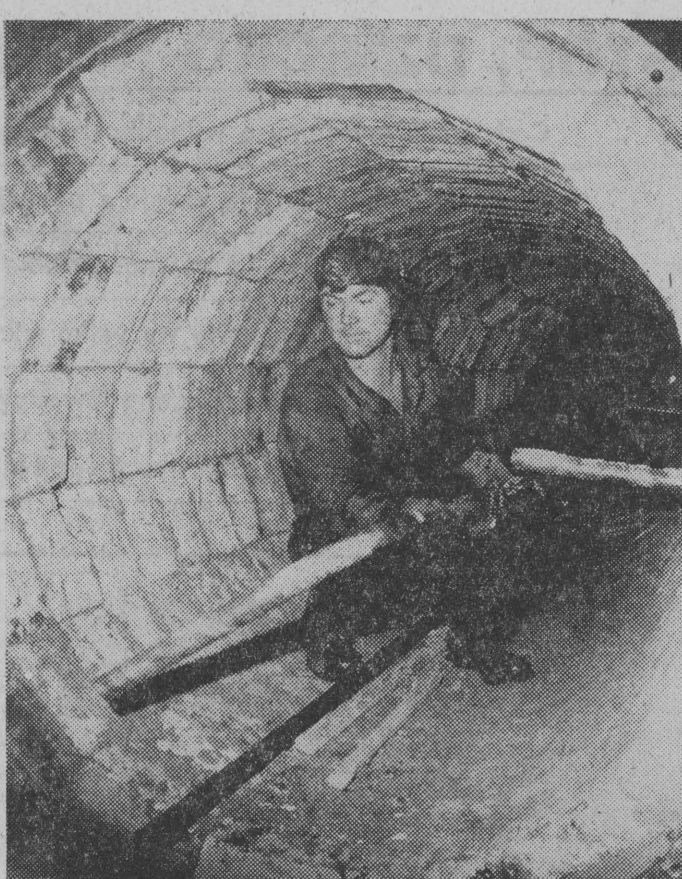
Warszawscy „mostostawcy” przy budowie nowych pieców obrotowych. Na zdjęciu Stefan Błażejczyk.
