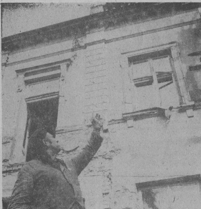
Dużo pracy trzeba będzie włożyć przy rekonstrukcji bardzo ciekawej elewacji od strony ogrodu.
