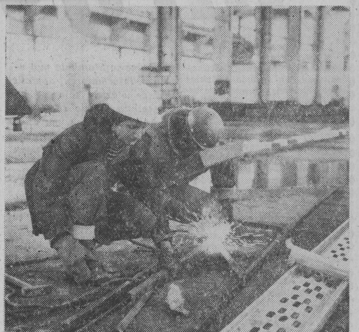
Aleksander Butkiewicz i Witold Dąbrowski z BPIE przy spawaniu konstrukcji energetycznych.
