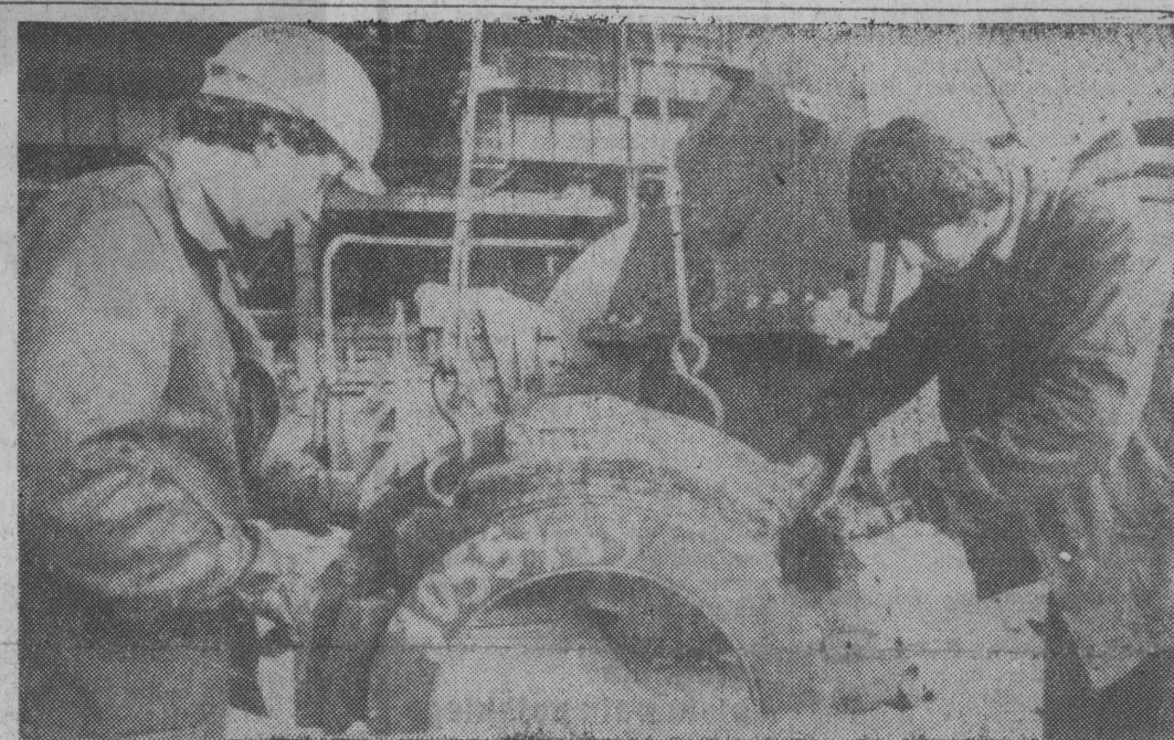
Elektrownia „JAWORZNO III” wroczyła w ostatnią fazę budowy. W ostatnich dniach włączono do krajowej sieci energetycznej V blok o mocy 200 MW, obecnie prowadzone są prace przy montażu ostatniego — VI bloku, którego uruchomienie przewiduje się w listopadzie br.
