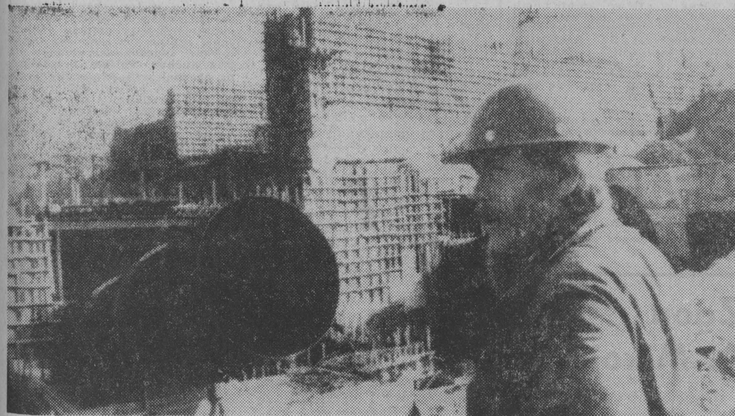
Jedną z największych inwestycji na terenie woj. gdańskiego jest budowa elektrowni w Żarnowcu. Główne prace koncentrują się przy wznoszeniu siłowni, gdzie wykonuje się roboty betonarskie. Wcześniej zamontowano już turbiny dostarczone z Czechosłowacji. Równolegle prowadzone są prace w hali montażowej, w której w przyszłości zostaną zamontowane urządzenia energetyczne.
