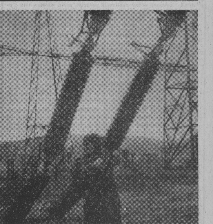
Trwają prace przy wznoszeniu elektrowni szczytowo-pompowej w Zarnowcu (woj. gdański). Zakończono już budowę części podziemnej hali montażu, wkrótce Energomontazh Północ rozpocznie nadmienią część hali. NA ZDJĘCIU: na placu budowy. CAF — Ukielewski — telefoto
