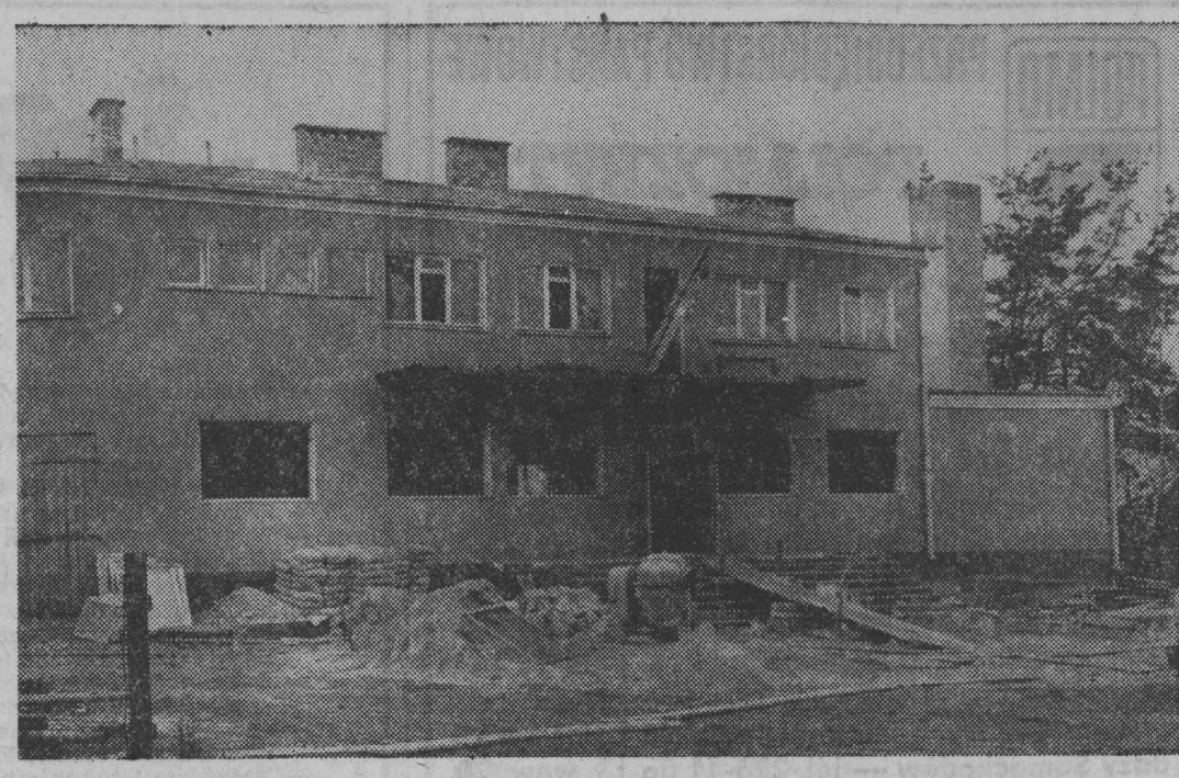
Budowa domu kultury. Fot. K. Świderski
