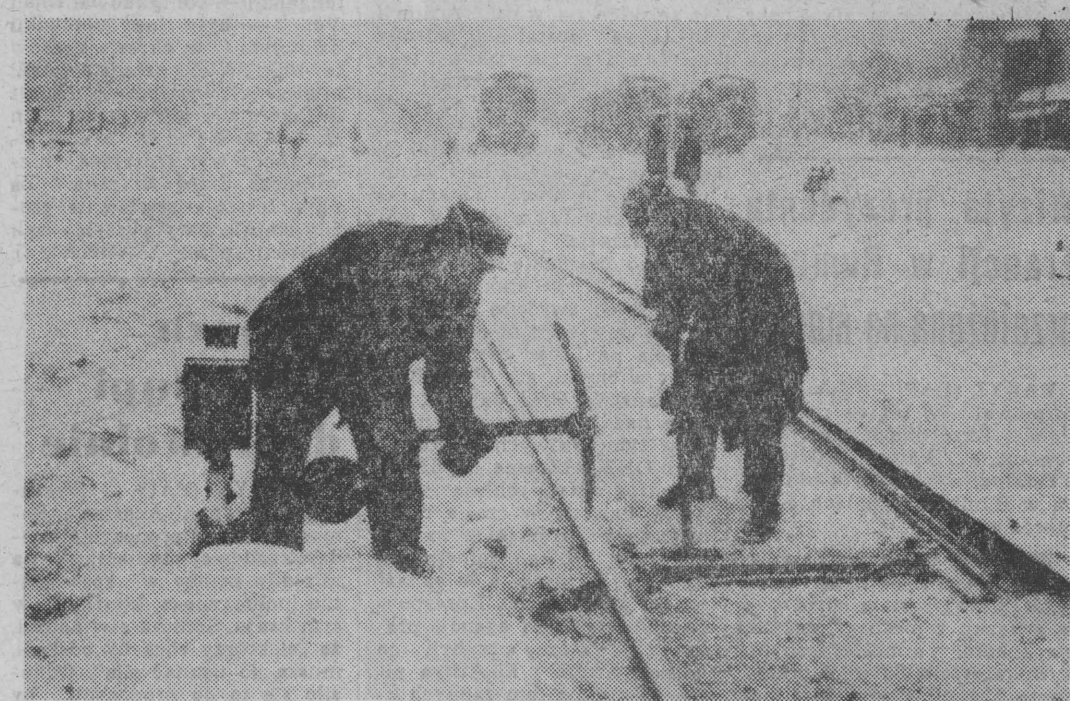
Tegoroczną zimą dotkliwie odczuwają pracownicy kolei. Obfite opady śniegu i niskie temperatury powodują zamrażanie szyn i rozjazdów. Kolejarze białostockiego węzła nie mają chwili wytchnienia. NA ZDJĘCIU: oczyszczanie torów i rozjazdów na białostockim dworcu PKP. CAF—Sienko—telefoto
