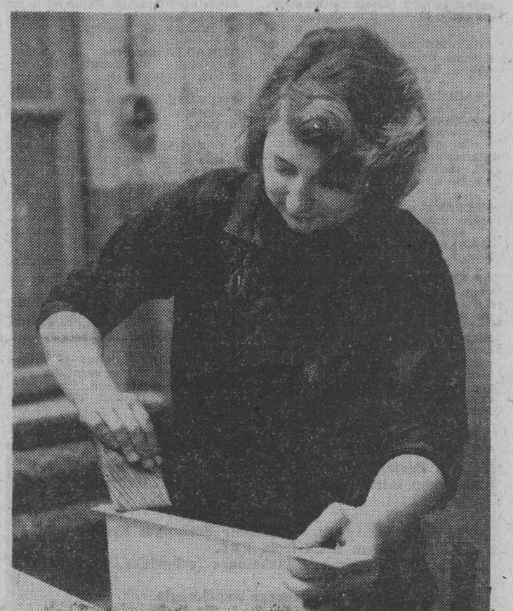
Przydałaby się prasa do pokrywania okleina wąskich krawędzi produkowanych elementów. Na razie jednak Barbara Deptula wykonuje tę czynność ręcznie.
