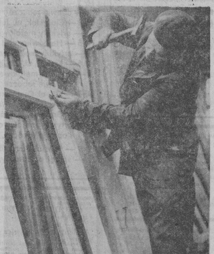
Na zamówienie odbiorców produkuje się w Czyżewie stolarkę okienną i drzwiową. Jan Gradowski, pracujący w zakładzie już ćwierć wieku, wykłada ramy okienne.
