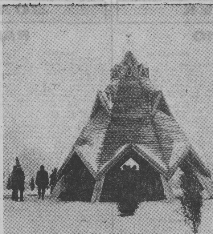
Ta oryginalna ośmiokątna piramida wysokości 10 metrów ustawiona została w geograficznym środku Węgier, w miejscowości Pusztavacs (okr. Pest). Obiekt, wykonany z żelazobetonu pokrytego drewnem, projektował József Kerenyi.
