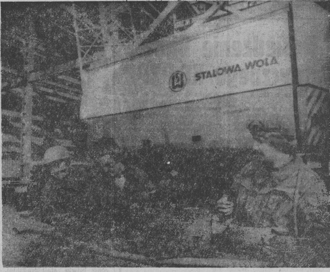
W Hucie im. Lenina trwa rozbudowa wydziału walcowni blach kaloseryjnych. Do czerwca br. mają zostać uruchomione dwa duże obiekty: wyżarzalnica oraz wytwórnia i wykańczalnia blach. Obiekty te zostaną wyposażone w nowoczesne urządzenia japońskie i austriackie. NA ZDJĘCIU: Ryszard Różga, Jerzy Kucharski i Leszek Mądry w czasie montażu konstrukcji. CAF — Sochor — telefoto
