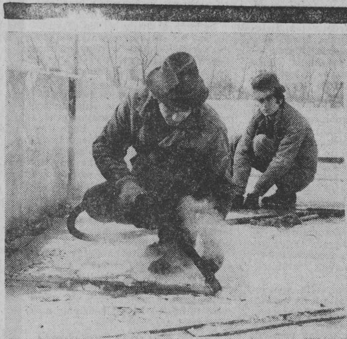
Wszystkie szparki między płytami trzeba dokładnie oczyścić ze śniegu i lodu. NA ZDJĘCIU: Jan Mróz i Jan Greś.
