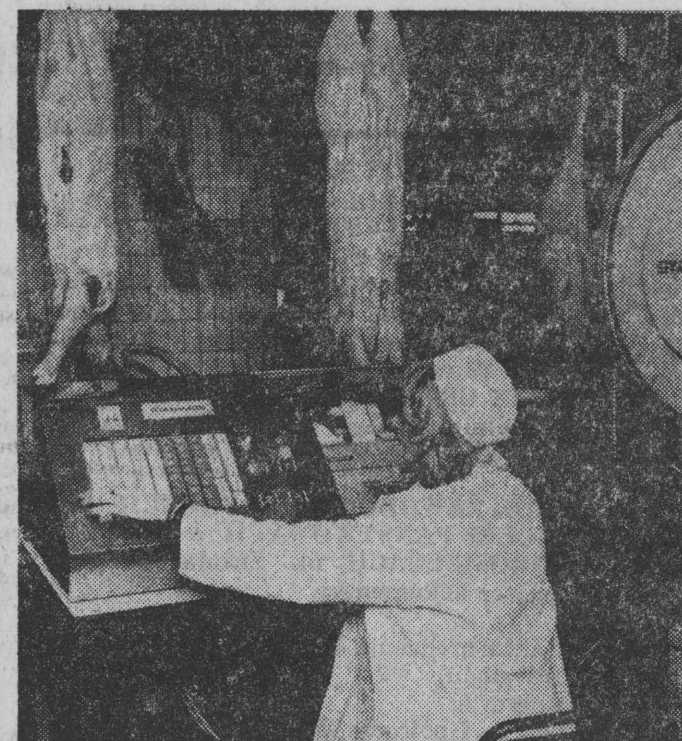
Waga — terminal komputera zainstalowany bezpośrednio na linii produkcyjnej obsługiwa Anna Małacka.
