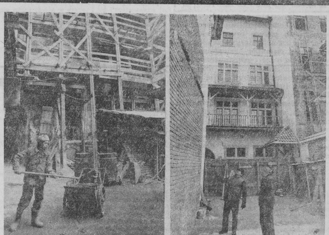
NA ZDJĘCIU: (z lewej) prace budowlane w kompleksie Wierzyńska. (z prawej) Kierownik budowy kompleksu Wierzyńska Bolesław Lutowski wraz z brzygadziwą Janem Żelaznym ustala przeprowadzanie prac dekarckich.
