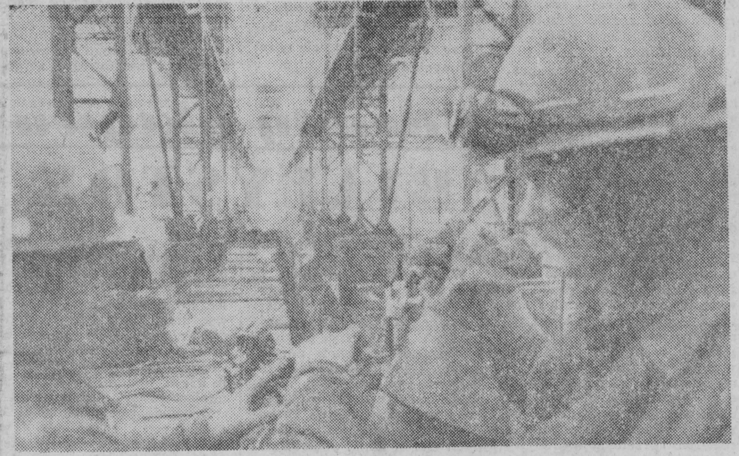
Budowana w Hucie im. Nowotki w Ostrowcu Świętokrzyskim (woj. kieleckie) walcownia drobna będzie największym tego typu obiektem w Europie. Rozruch pierwszych obiektów nastąpi w lecie, a pod koniec roku ruszy gorące walcowanie. Procesy technologiczne w nowym zakładzie będą w pełni zautomatyzowane. NA ZDJĘCIU: budowa walcowni drobnej w Hucie im. Nowotki w Ostrowcu Świętokrzyskim. — Stan — telefot
