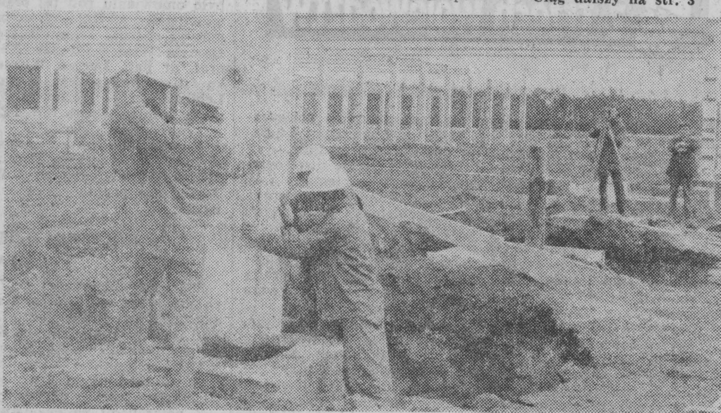
Trwa montaż głównego budynku produkcyjnego zakładów drobiarskich. NA ZDJĘCIU: brygada Zygmunta Kondratowicza stawia słupy strunobetonowe. Zdjęcia: K. Świdorski
