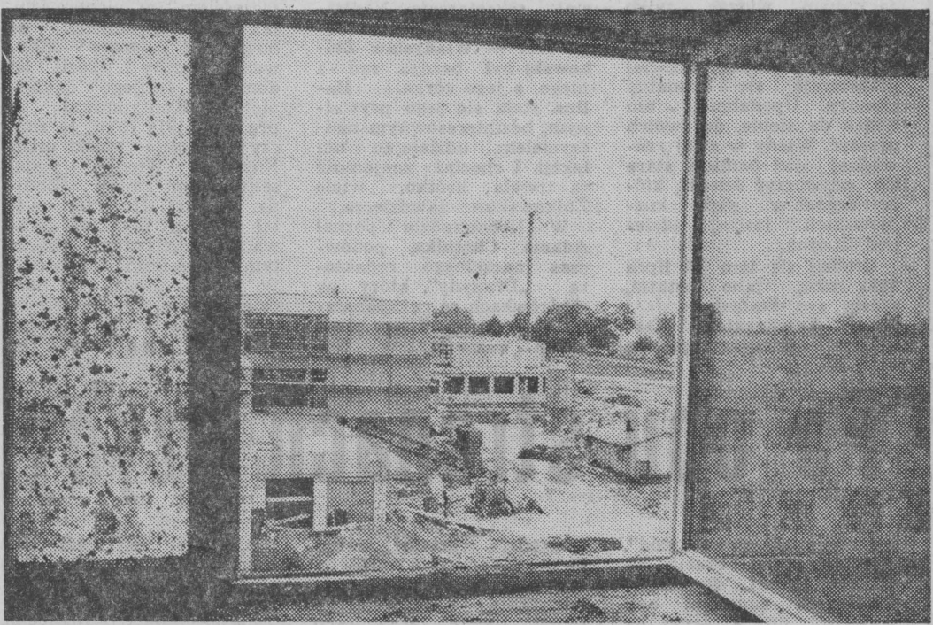
W połowie czerwca br. nasz fotoreporter uwiecznił taki oto widok na nową szkołę w Małym Plocku, z okna mieszkania nauczycielskiego. W końcu sierpnia br. obiekt zostanie oddany do użytku.
