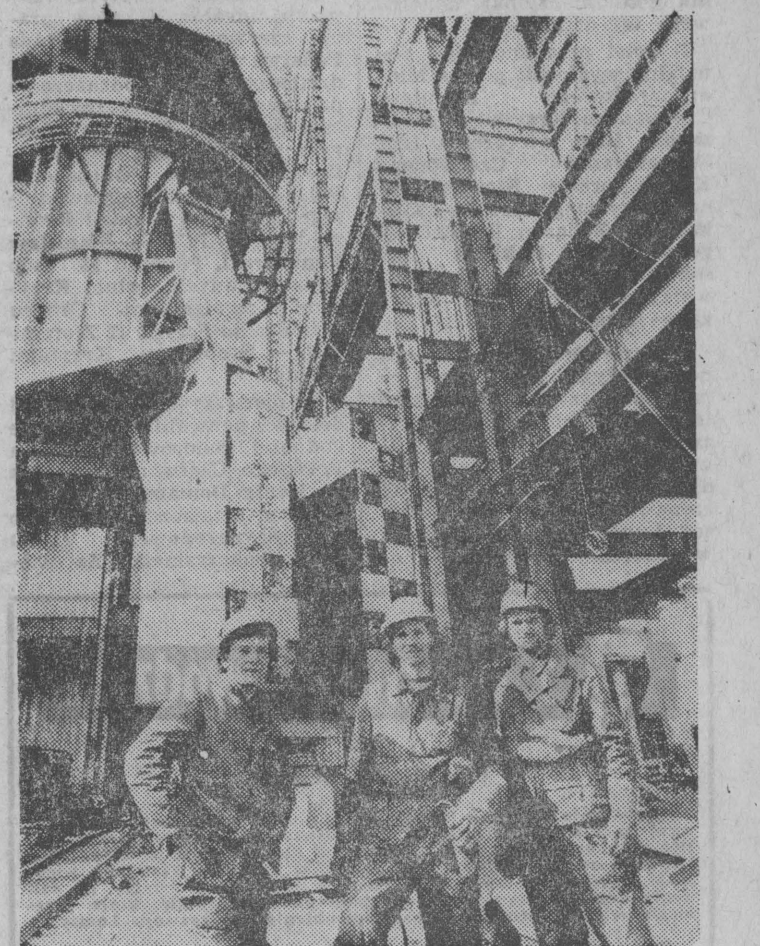
Trwa budowa najwięk- szej w kraju inwestycji energetycznej — bieżącego roku w Polańcu (woj. tar- nobrzeskie). Obecnie więk- szość prac koncentruje się na montażu konstrukcji i urządzeń pierwszych trzech bloków. Uruchomienie pierwszego turbozespołu nastąpi w sierpniu br. Kolejne dwa bloki będą przekazane do eksploata- cji do końca br. Łącznie 600 MW z Polańca zasili w 1979 roku krajowy sys- tem energetyczny.
