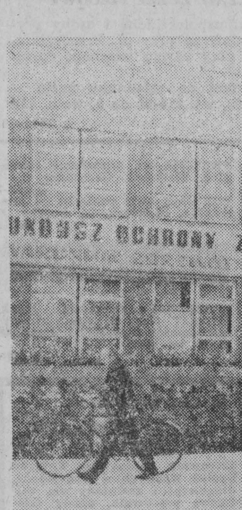
Przychodnia Rejonowa w Brańsku oddana przed pięciu laty, wybudowana przy dużym udziale czynu społecznego.
