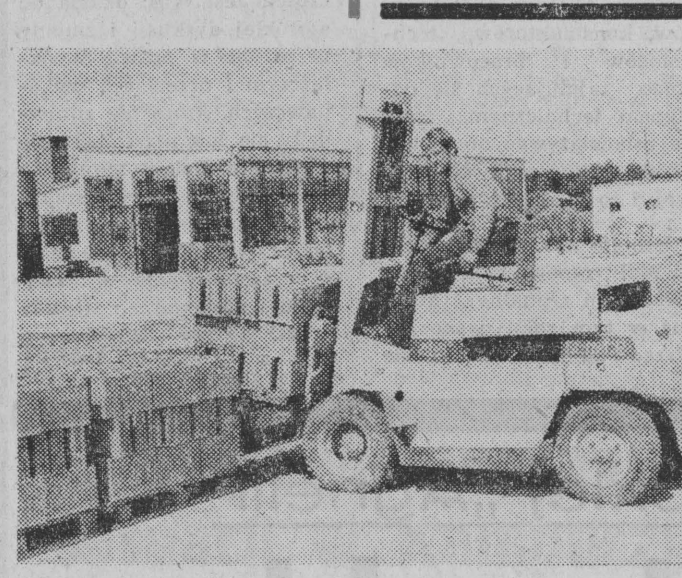
Co kilka minut pastczarka kładzie na betonie porcję pustaków. Fot. S. Kulikowski
