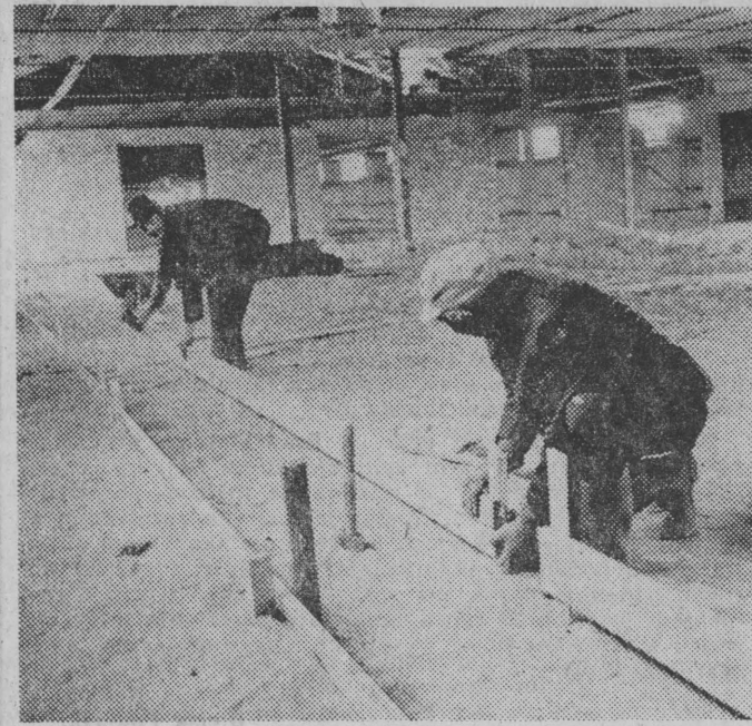
Przy wykonywaniu posadzi pracuje brygada Mariana Jackiewicza. Fot. Z. Lenkiewicz
