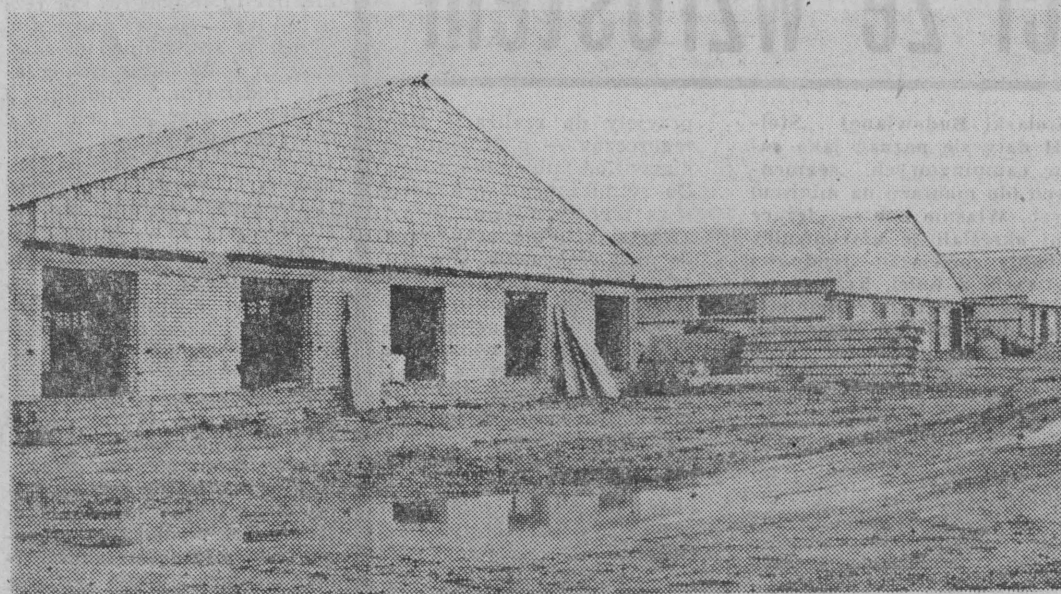
Część budynków fermy stoi już pod dachem.
