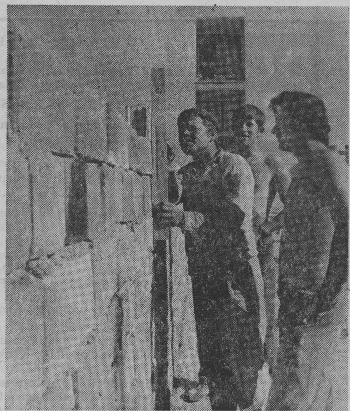
Junacy z OHP w PISZU poznają tajniki murarstwa od inżyniera Tadeusza Burakowskiego. NA ZDJĘCIU: rozbudowa miejscowego Zespołu Szkół Zawodowych.
