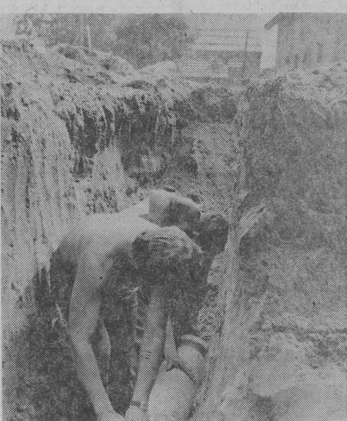
Roboty kanalizacyjne prowadzą pracownicy Przedsiębiorstwa Budownictwa Komunalnego z Giżycka.
