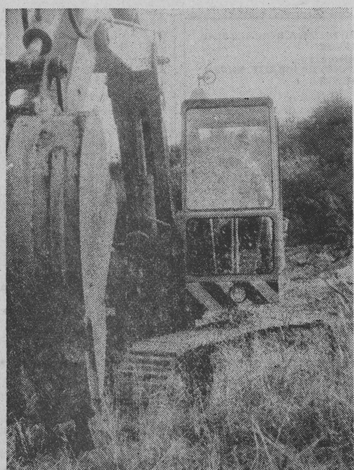
Przy drugiej trasie zjazdowej na Pietraszach prowadzone są prace odwadniające teren. NA ZDJĘCIU: seregowy Andrzej Kopacz przy wykonywaniu koparką kanału, odprowadzającego wodę.
