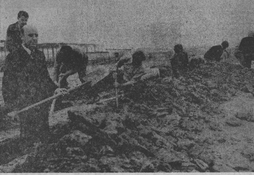
Pracownicy Fabryki Dywanów „Agnella” w Białymstoku w Cynie Partijnym wykonują wykopy pod kabel energetyczny do swoich budujących się zakładów. Fot. K. Świdorski
