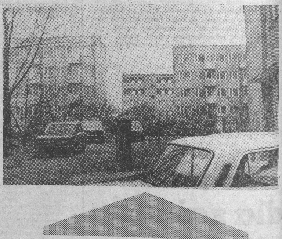
Osiedle Sady. Tu powstaje większość przekazywanych ostatnio bloków. Tu także rodzą się budowlane poślizgi.
