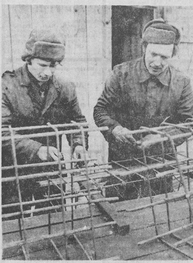
Przed przystąpieniem do betonowania konieczne jest wykonanie zbrojenia, które musi być dokładnie wykonane. Na zdjęciu: Andrzej Rogala i Antoni Maksymowicz — zbrojarze z augustowskiego oddziału WZSR.
