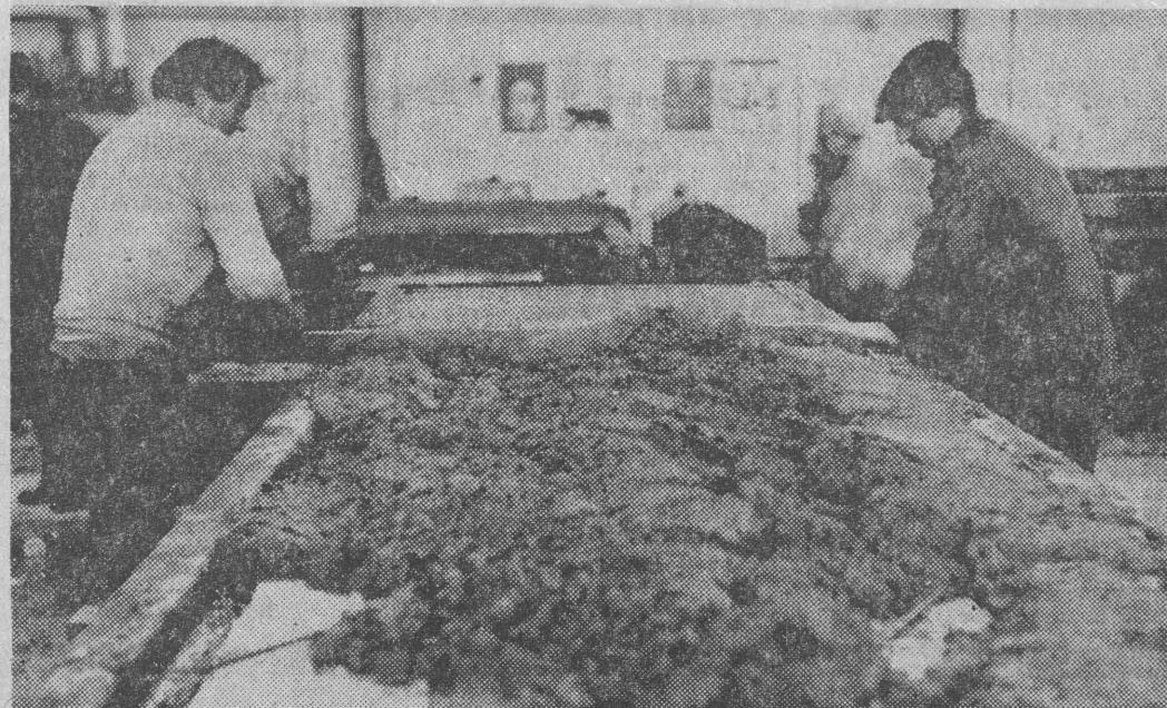
Z tej na pozór bezkształtnej masy powstanie za chwilę element ściany zewnętrznej bloku. Czesław Taliński i Henryk Ficewski wykonują operację, zwaną fachowo układaniem warstwy fakturowej ściany.
