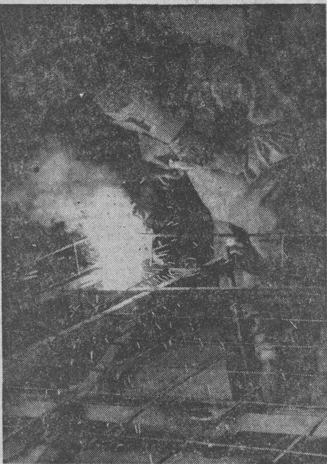
Tu zaczyna się proces powstawania prefabrykatów, składających się na nasze mieszkania. Na stanowisku przygotowania zbrojenia do form bateryjnych spawaniem metalowych prętów zajmuje się Ryszard Czajkowski.
