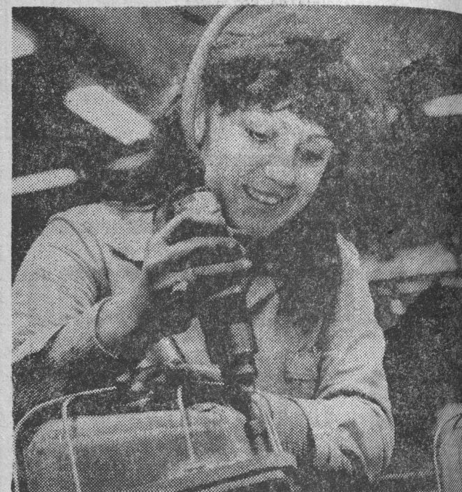
Ewa Jędrzejewska montuje oprawę kanałową.
