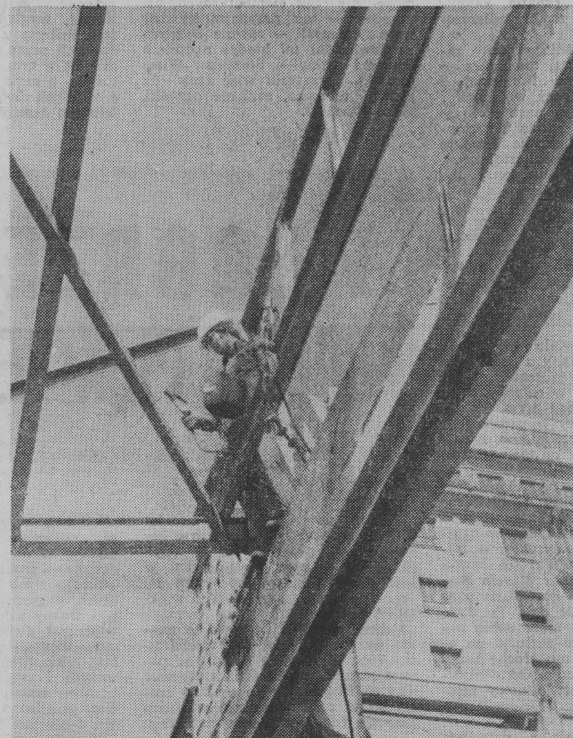
Mirosław Tangul spawia elementy wierzania dachu.
