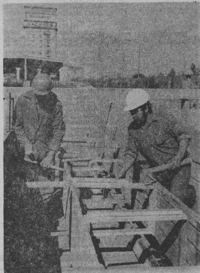
Przygotowanie szalunku pod fundamenty zajezdni lokomotyw. Pracują cieśle: Remigiusz Zaleski i Józef Kolnierowicz.
