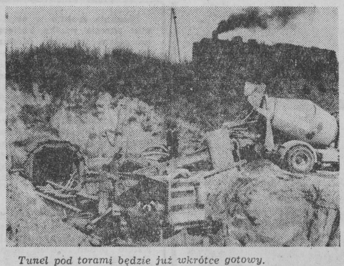
Tunel pod torami będzie już wkrótce gotowy.
