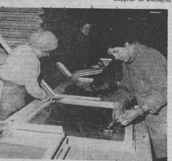
Szklenie i kompletowanie okien.
