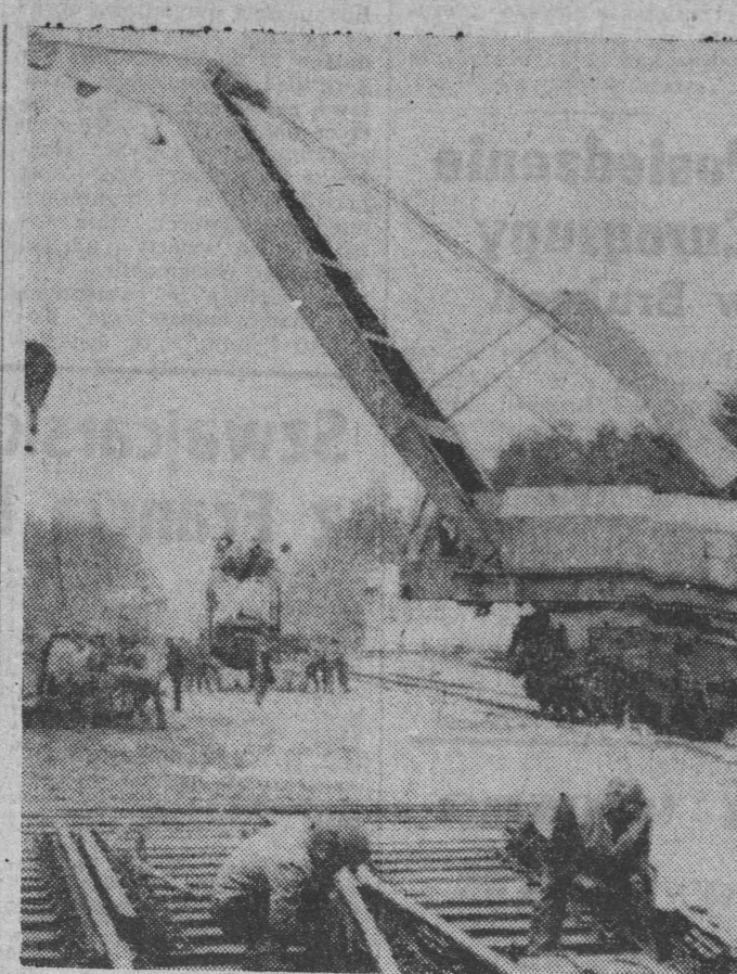
Wielkim sukcesem budowniczych Linii Hutniczo-Starkowej zakończyła się akcja przebudowy węzła kolejowego na stacji Zwierzyniec. Dzięki doskonałej koordynacji pracy ludzi, ciężkiego sprzętu budowlanego i kolejowego dokonano korekty położenia torów i rozjazdów linii normalnej i szerokotorowej. Jest to akcja bez precedensu w historii nie tylko naszego kolejnictwa.
