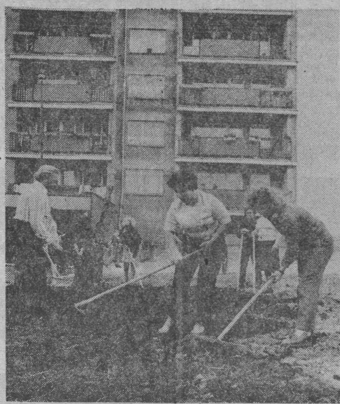
Za sprawą pracowników Urzędu Pocztowego w Elku, znikają śmieci z bloków Osiedla Północ i ostatnie ślady budowlanego gruzu i wykopów.
