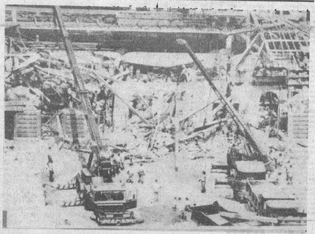
Dramat w Bolonii. Wskutek eksplozji bomby na dworcu kolejowym śmierć poniosło wiele osób. Do tej pory spod gruzów budynku wydobyto 83 ciała zabitych. Ponad 200 osób zostało rannych. Ekipy ratownicze nadal przeszukują rumowisko. NA ZDJĘCIU: ekipy ratownicze w akcji.
