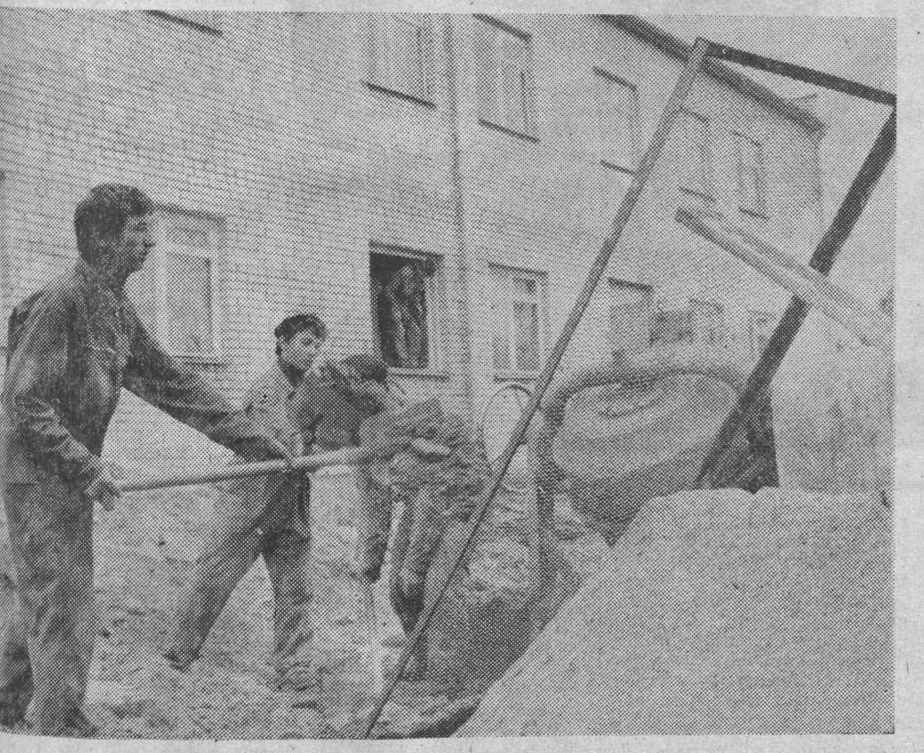
Chętnie pracują przy budowie internatu i stołówki.
