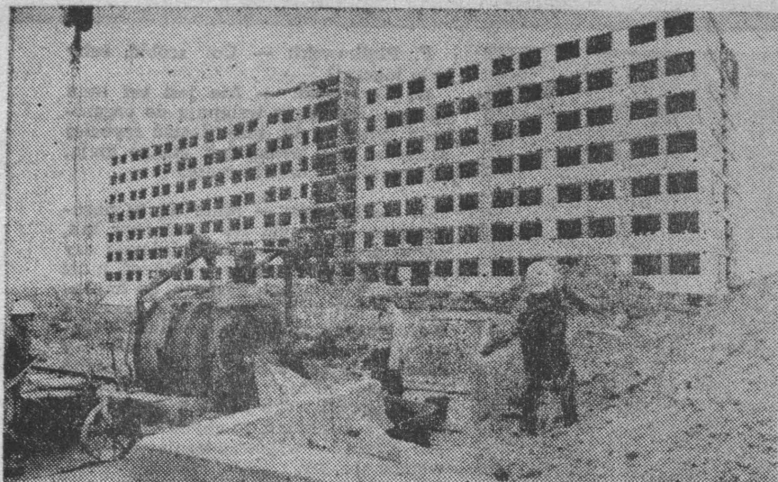
W Belchatowie (woj. łódzkie) wzniesiony jest przez Przedsiębiorstwo Budowlane „BUDOPOL” szpital na 935 łóżek. Koszt budowy szpitala wynosi 650 mln zł, a przewidywany termin oddania do użytku — to grudzień 1983 r.
