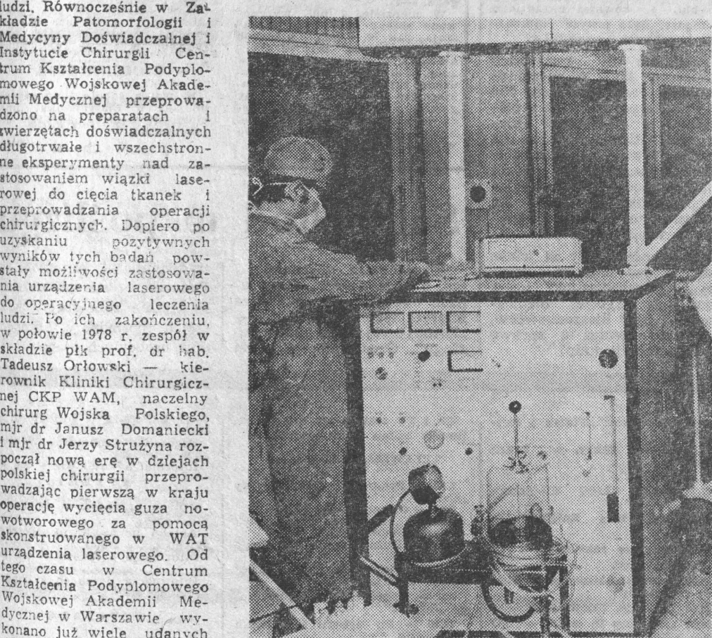
NA ZDJĘCIU: Urządzenia laserowe do zabiegów chirurgicznych konstruowane w Instytucie Elektroniki Kwantowej Wojskowej Akademii Technicznej. Tu powstaje wiązka promieniowania laserowego i stąd przenoszona jest do laserowego skalpela.
