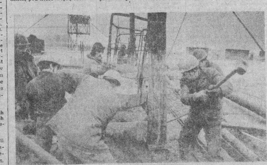
Trwają nadal intensywne przygotowania do ugaszenia pożaru w Szybie Daszewo-1 k. Karłina. NA ZDJĘCIU: brygada Juliana Krausa z Przedsiębiorstwa Poszukiwań Naftowych z Piły montuje urządzenia Wierni R-1 do wiercenia otworu ratunkowego (zgodnie z trzecim wariantem likwidacji pożaru)
